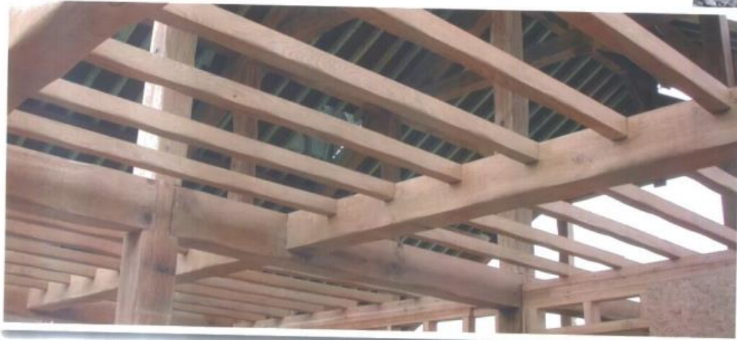
Figure 17 : Les bois de structure à section rectangulaire et le classement pour leur résistance
